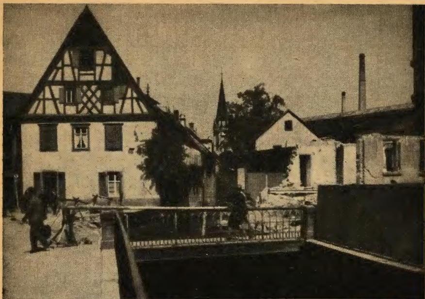
Kriegsschäden in der Markgrafstraße
