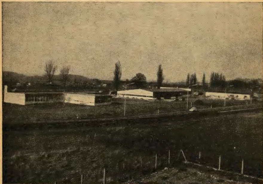
Das Industriegebiet an der Freiburger Straße
