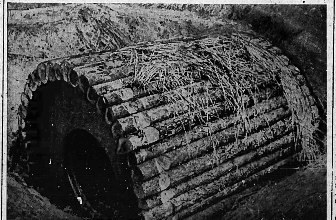
Ein Bombenrichter als Bett für den Rollbunker. Vier Mann haben Platz in ihm, finden trockene und gegen Granatsplitter gesicherte Unterkünfte. EM. PK.-Aufnahme H-Kriegsbericht Kurjuhn (Wb.)
