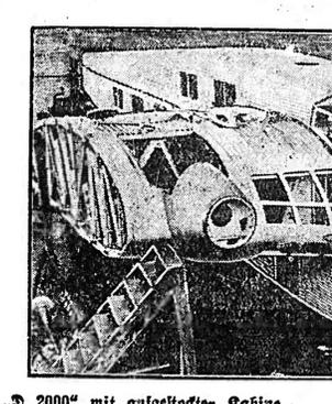
„D 2000“ mit aufgestockerter Kabine.
