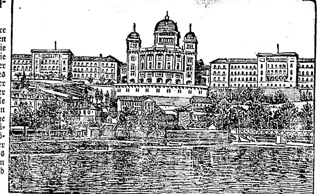
Das Songo-Grenzgebäude in Bern.
