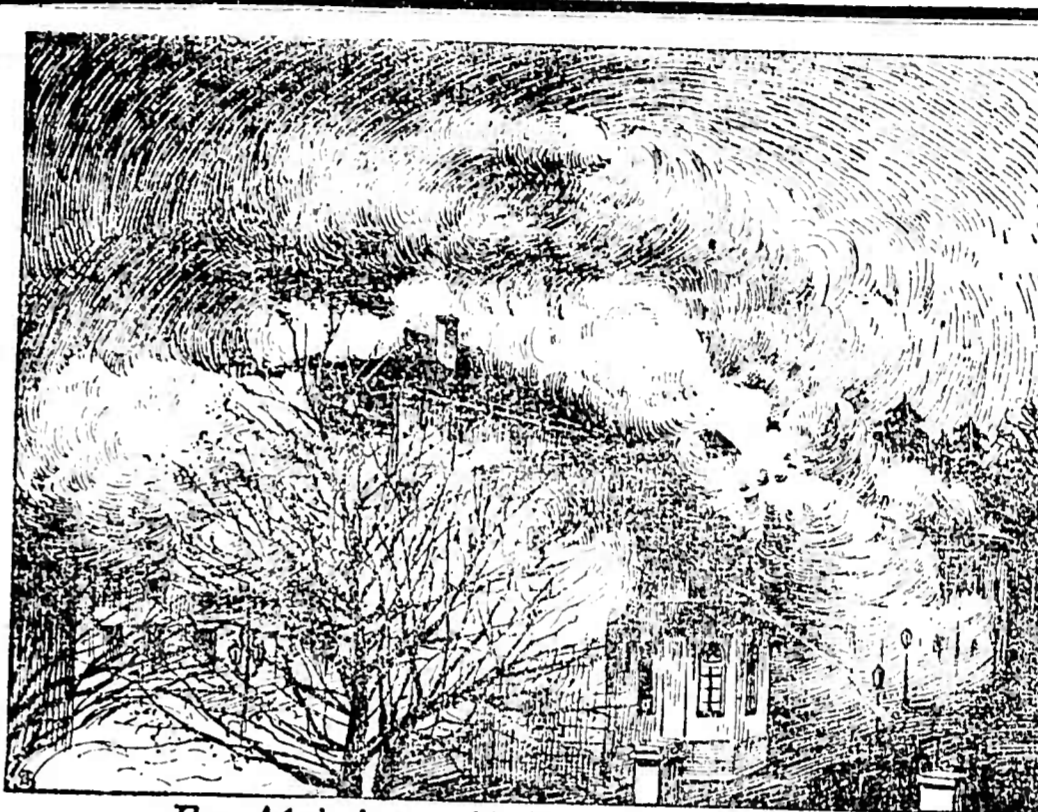
Das Meininger Hoftheater in Flammen
