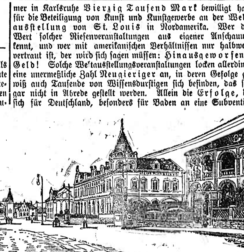
Die Hohenzollernstraße in Kantschou, im Hintergrunde der Bahnhof.
